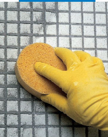
Terminación del emboquillado de mosaico vítreo con esponja
