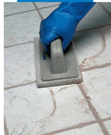
Terminación con Scotch-Brite®
