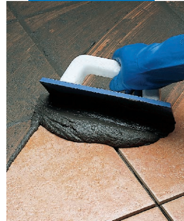
Relleno de boquillas de monococción, con lana
