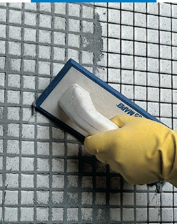
Emboquillado de junta de revestimientos de mosaico vítreo (en baño) con llana
